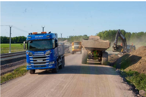
Mye tungt utstyr i sving på anlegget med køkjøring på anleggsveien. Skimmene er lagt, kontaktledningsanlegget er påbegynt.
