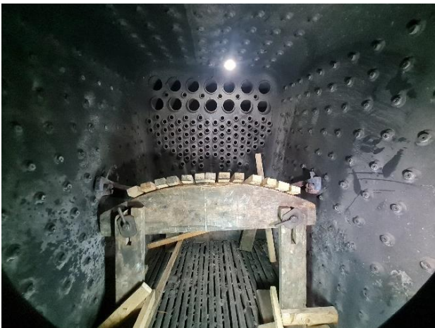
Reisverk for støping av nytt hvelv Foto: Kristian Ruud Nøkleby
