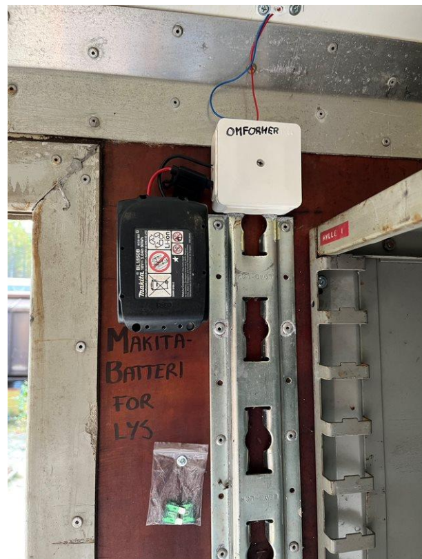
Adapter til Makitabatteri gir lys i ledstripene i taket. Foto: Alexander Westerlund
