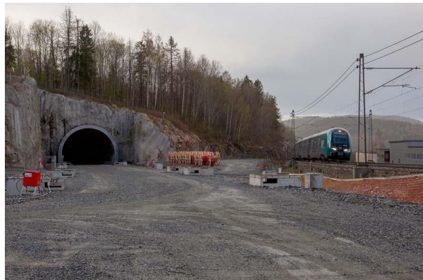
Drammenstunnelen munner ut i Kobbervikdalen, der den møter Vestfoldbanens trasé fra 1881.
