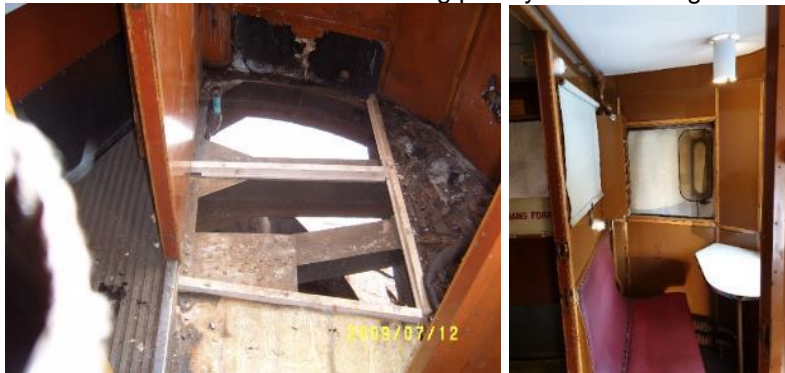
Før og etter i konduktørrommet i ende 1. Foto: Morten Håland
