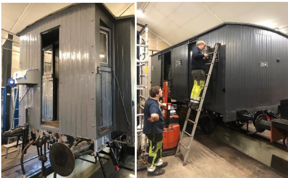
Gavlveggen ble utbedret for råteskader og fikk delvis nytt panel. Til høyre foregår montering av skilt. Foto Henrik B. Backer
