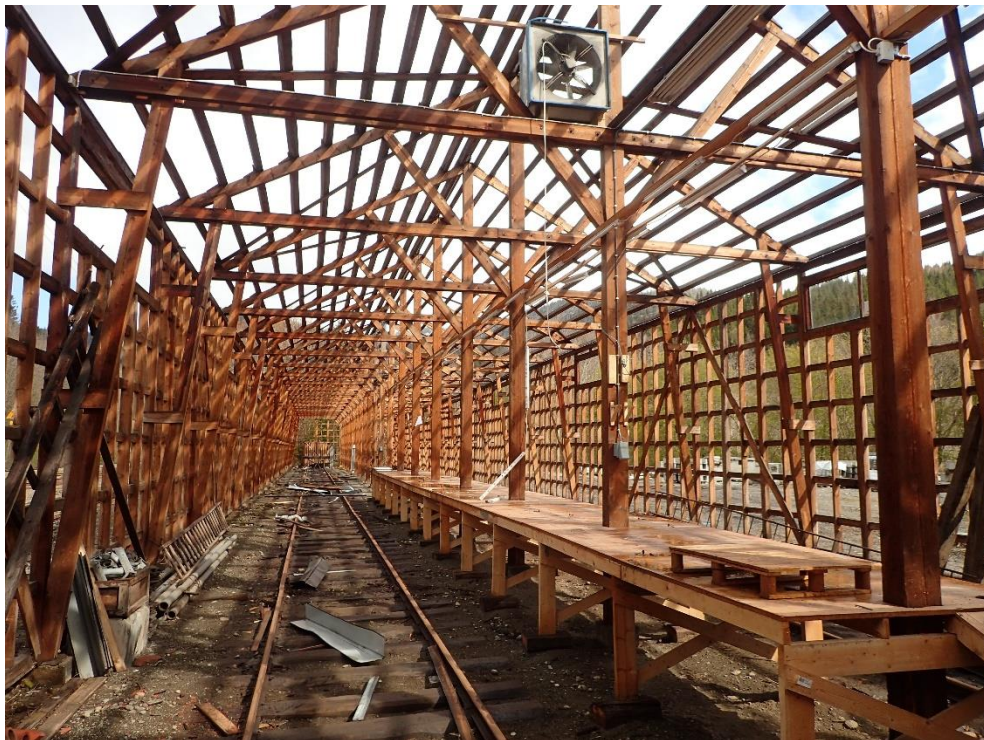
12 mai 2020. Alt av eternitt er fjernet. Nå er det snakk om dager før treverket rives.
