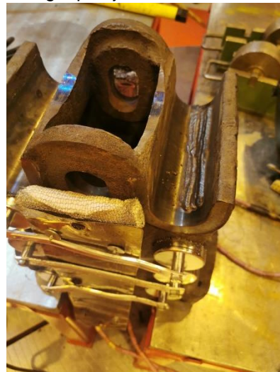
Pendelstykket under kontroll der sprekke ble funnet og under reparasjon med varmematte og det hele hos Aker Solutions (garantireparasjon 109 år etter leveransen). De ansatte stilte opp på egen tid for å hjelpe oss. Foto: Henrik B. Backer (t.v.) og Pål Stian Wahlquist (t.h.)
