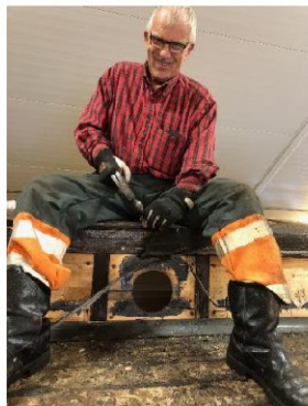
Per Kjeldaas renser taket for gammel spiker. Foto Henrik B. Backer
