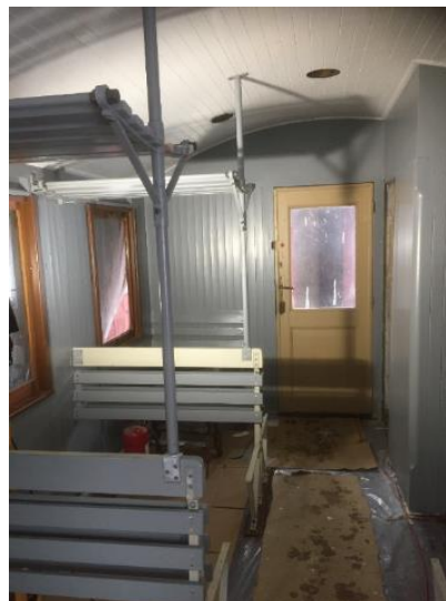
Innredningen i Co 195 ble montert opp i løpet av året.
