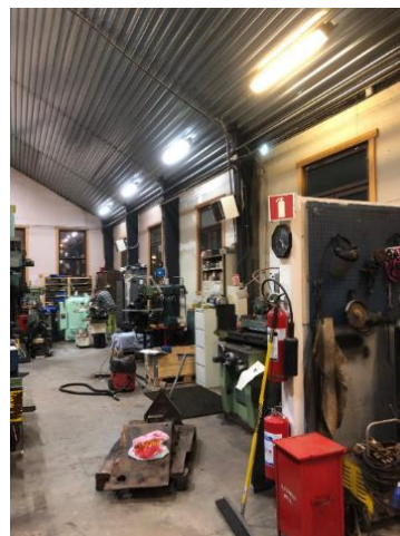
Skilleveggen i verkstedet er tatt ned. De tre borteste lysarmaturene er skiftet til LED-lys Foto Henrik B. Backer
