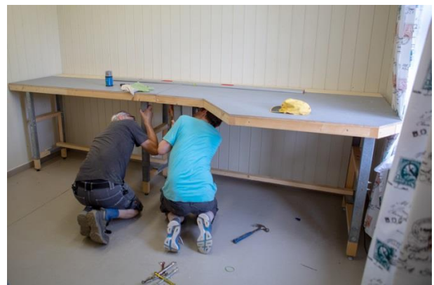
... de er også montørene som sørger for å få de to seksjonene mot nord på plass. Dette arbeidet kan gjøres helt uten bruk av verktøy.
