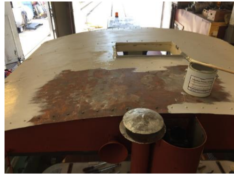
Taket på Skd 214.103 ble fullstendig rengjort for gammel maling, og grunnnet og malt. Takluken er tatt av for utbedring. Foto Henrik B. Backer
