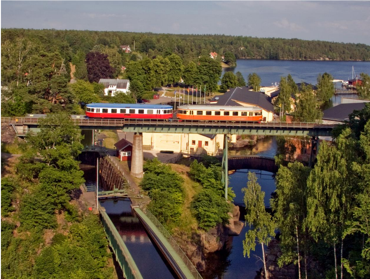
Chartertog på Håverud viadukt 30.06.2009 (LHR)
