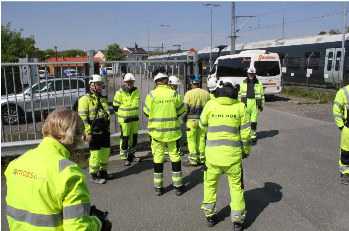
Under: En siste briefing før det bærer inn i tunnelen. (Gylmer Bach)
