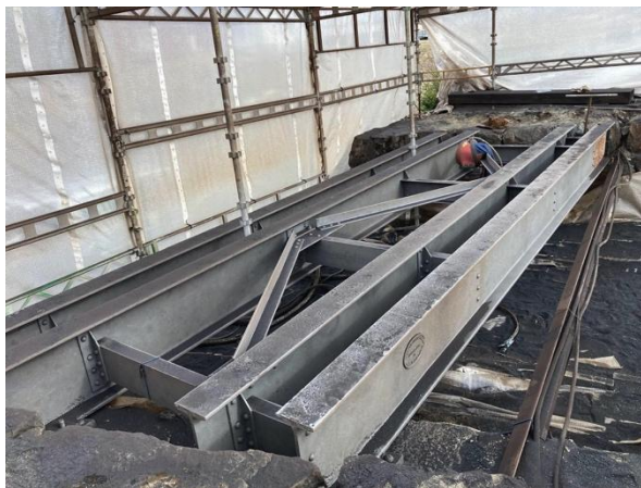
Etter sandblåsing og maling. Foto: J. E. Asbjørnhus
