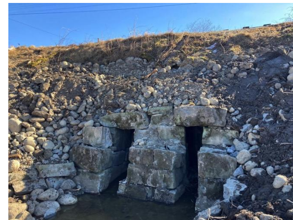
Stikkrenne for Gråbekken, Sysle
