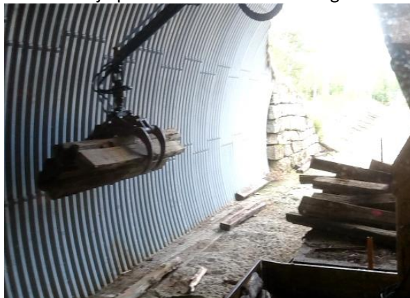
Foto: Sviller hentes inn i tunellen. Foto: H. Hagen
